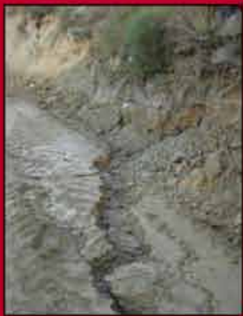
Día 3 de septiembre de 2008. Primer llenado de la balsa y primeras fugas
