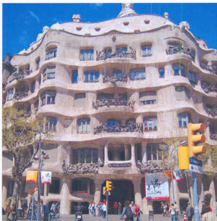
Lámina 3. Fachada de la Casa Milà o La Pedrera , ANTONIO GAUDÍ, 1905-1910. Barcelona.
